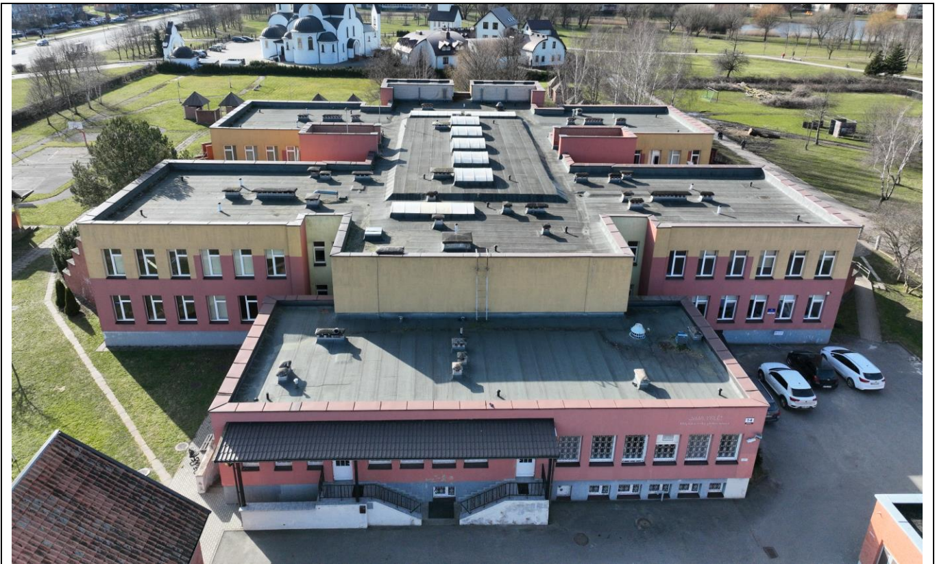
3. pav. „Pastato vaizdas iš stovėjimo aikštelės pusės” (R fasadas)
